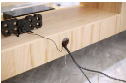
◀ 電視櫃中抽屜背板位置 加挖出線孔
